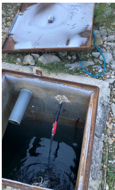
Diumenge dia 22 de gener se va procedir a buidar la canonada d'aigua que va de la cisterna al mas. Això se fa per evitar congelacions de la canonada. El cademat de la cisterna estava trencat, serà substituït la pròxima setmana.
