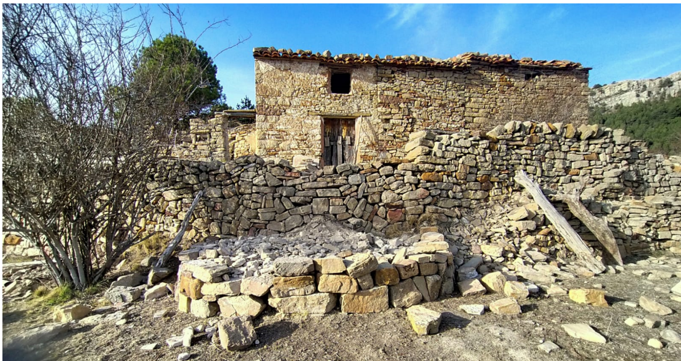
Continúan las labores de desescombro (tierra, cal, piedra y teja) de la masia y se aprovecha para reforzar con contrafuerte un muro con tendencia a desmoronarse. Asimismo se ha realizado un muro de piedra en seco circular.
